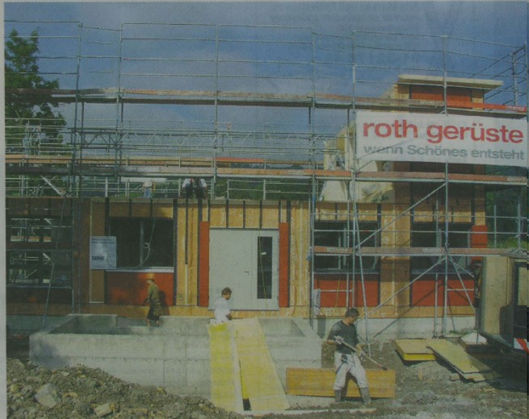
Das abschirmende Gitter aus Kupferdraht ist vor der Fassadenmontage noch sichtbar. BILDER.PD
